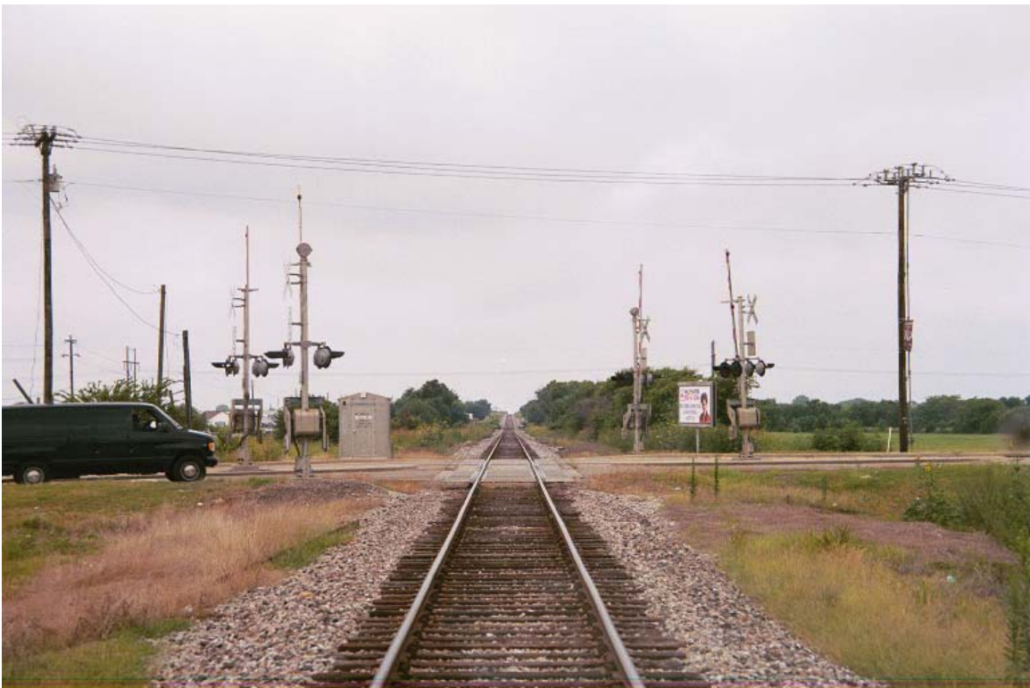
MP 786.6 Ovilla Rd
